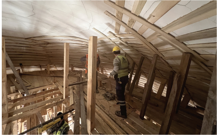
Adıyaman'daki KAP Camii'nde restorasyon.
