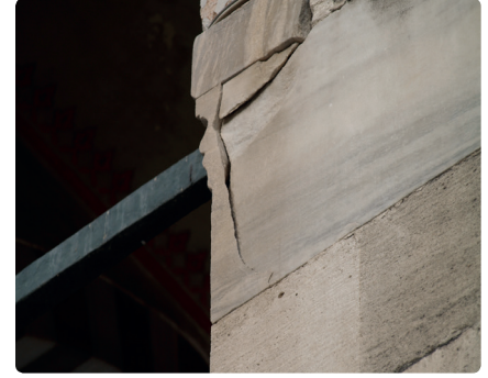
c) Gergi çubuğunun doğal taş çatlatması (F. Aköz)
