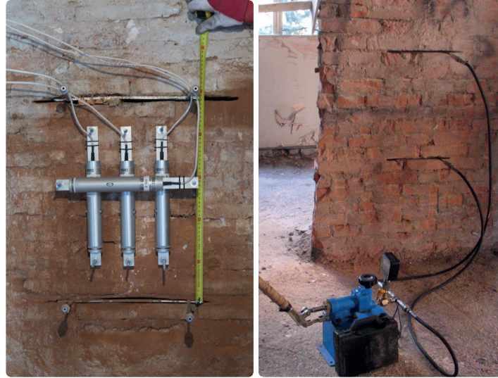
Şekil 3.4 Yığma duvarda gerilme deneyi (flat-jack) uygulamasına örnekler (F. Kuran; O. Aydemir)
