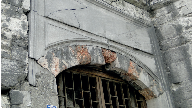
Şekil 4.15 * 'in retorasyonunda kemerde beton blok kullanımına örnek (Z. Ahunbay)
