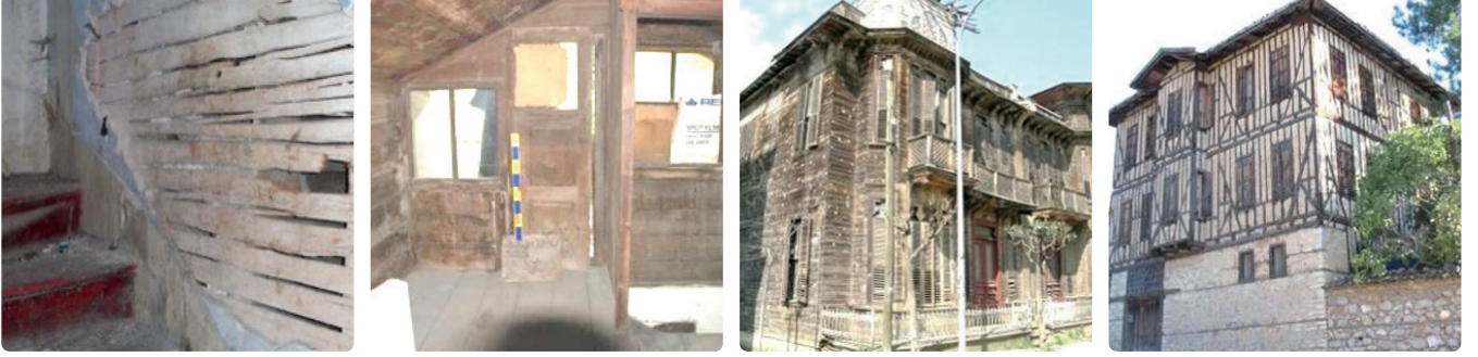
a) Temel duvarı üzerinde, b) Alt kat yığma duvarları üzerinde, c) Dikmeler üzerinde, d) Tek kolon mesnedi
