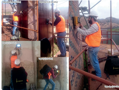
Şekil 3.3 Yapı içinde ve dışında jeoradar uygulaması (VGM Arşivi)
