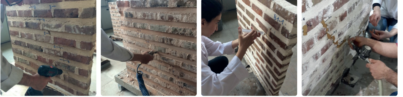
Şekil 7.2 a) Duvar üzerine matkap ile delik açılması, b) Açılan noktaların hava ile temizlenmesi, c) Islatma işlemi, d) Enjeksiyon uygulaması
