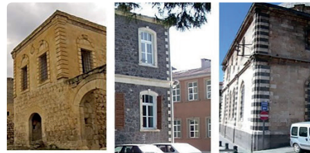
Duvar; a) Kendine dik duvaralar, b) Duvar kalınlaştırılması ya da c,d) Destek ayakları (fotolar: G.Arun)
