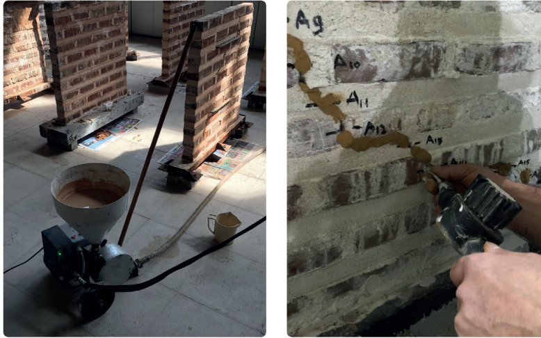
Şekil 7.1 a) Enjeksiyon cihazı, b) Cihaz ucundaki barometre
