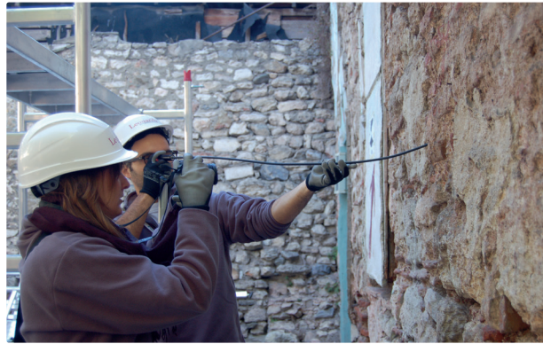
Şekil 3.6 Yapıda endoskopinin uygulanması (O. Aydemir)
