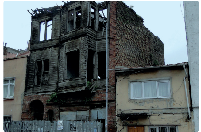
Şekil 4.9 Yangın görmüş ahşap yapı (Z. Ahunbay)
