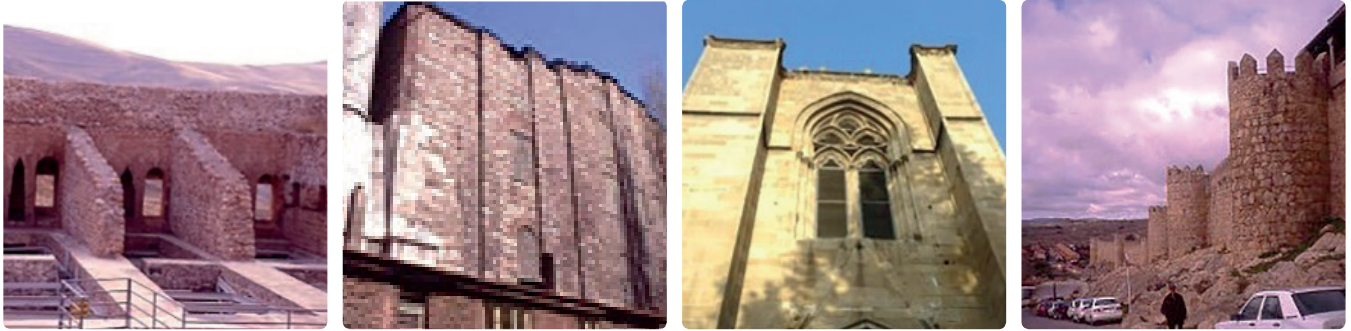
Duvar; a) Kendine dik duvaralar, b) Duvar kalınlaştırılması ya da c,d) Destek ayakları (fotolar: G.Arun)
