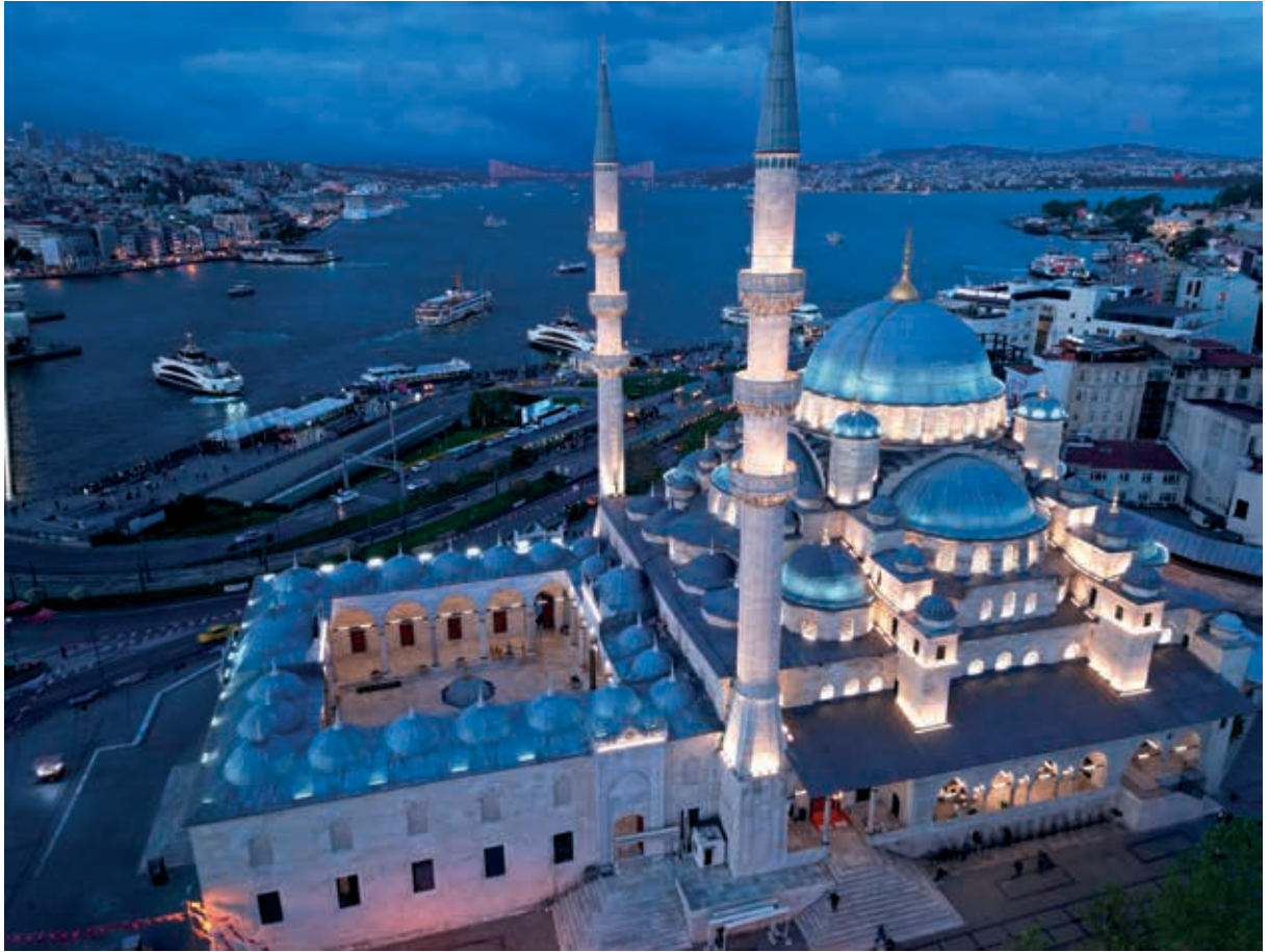
Restorasyon sonrası caminin dronla çekilmiş dış cephe ve üst ölçek fotoğrafları (GETA İnşaat)
