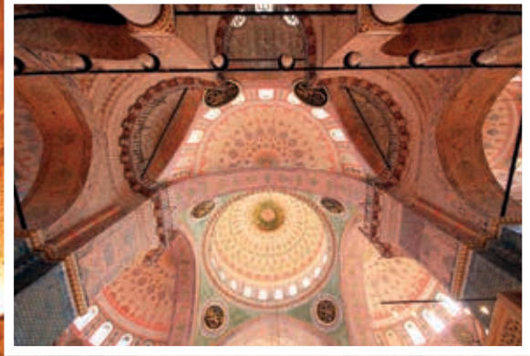
Cami üst örtü sisteminin ve kalem işine ait detayların görünüşü (GETA İnşaat).
