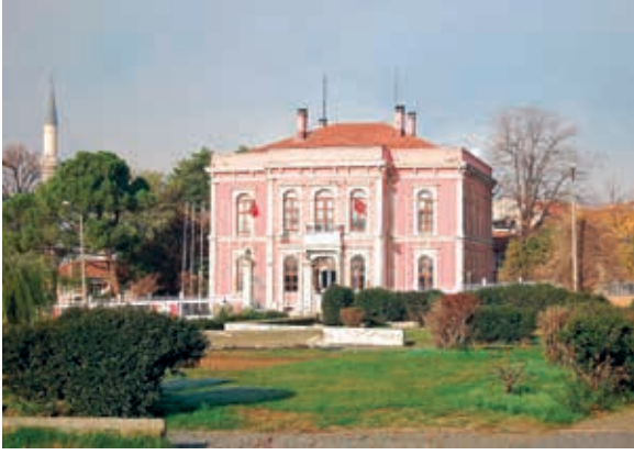
Şekil 8 Belediye binası (M. Sav, 2013)
