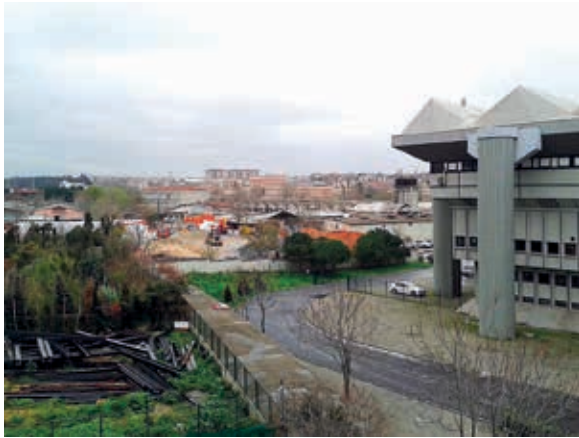
Şekil 1 Taşınmazın yatırım öncesi hali
