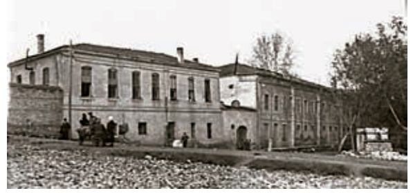
Şekil 10 Istabl-ı Amire'nin deniz tarafındaki giriş cephesi
