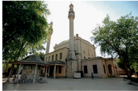
Restorasyon öncesi genel görünüm
