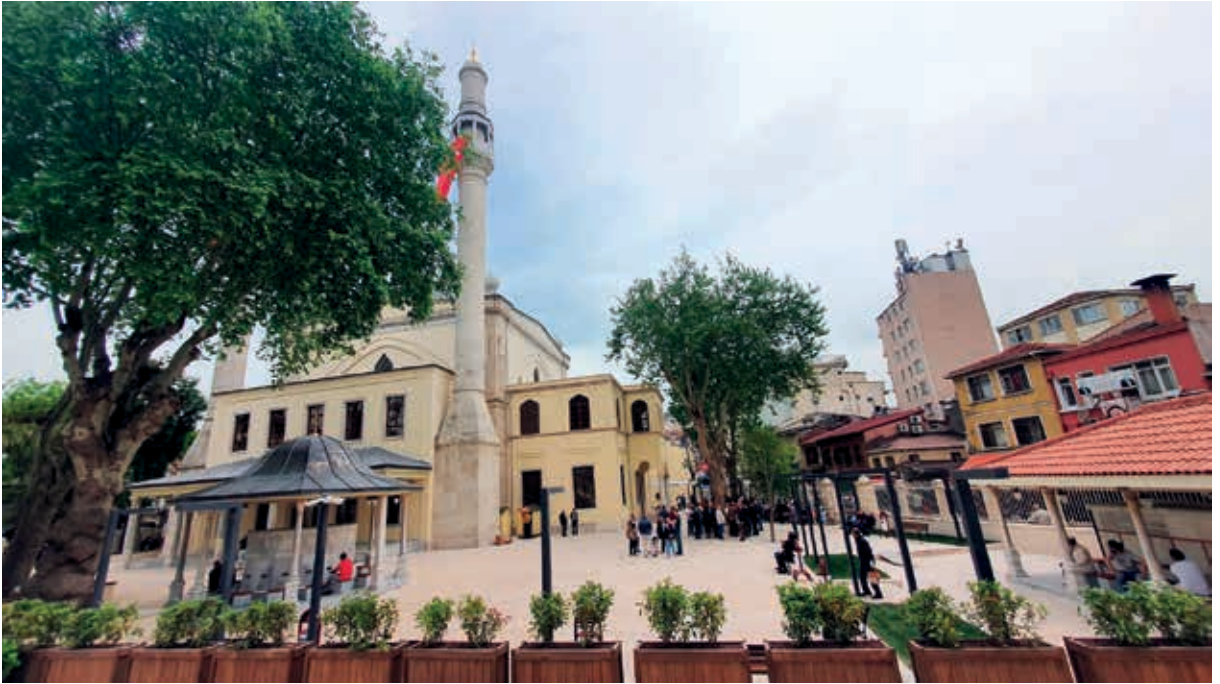
Restorasyon sonrası camiden genel görüntüler (Pekerler Restorasyonu)
