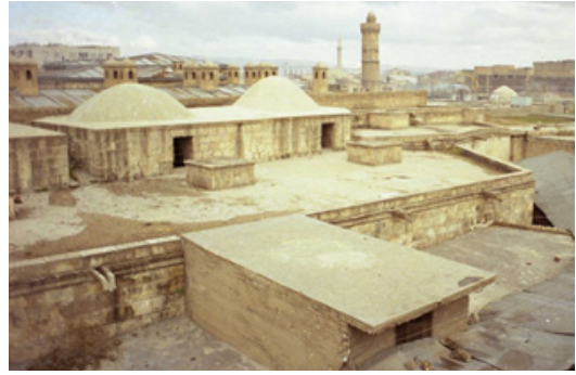
Fotoğraf 3: Çeşitli yüksekliklerde teşkil edilmiş üst örtü (Kürkçüoğlu Arşiv)
