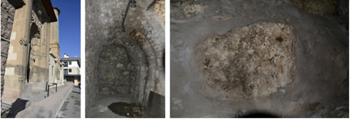
Fotoğraf 5,6,7: Bahçe duvarında, bodrumda çimentolu harç kullanımı ve eriyen taş örneği
