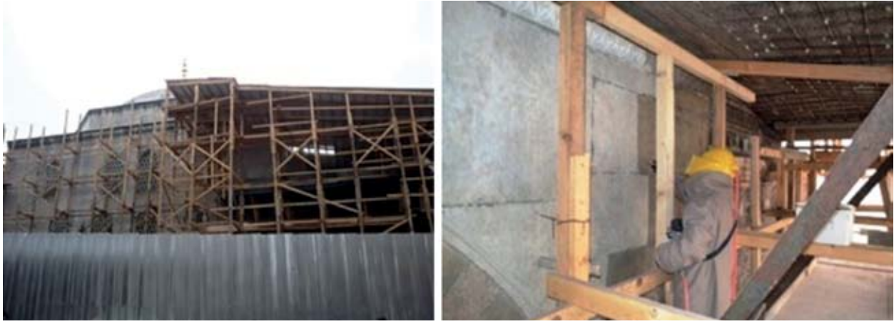
Şekil 15. Hatice Turhan Valide Sultan Türbesi mermer yüzey mikro kumlama (İ. Billur Arşivi, 2014).
