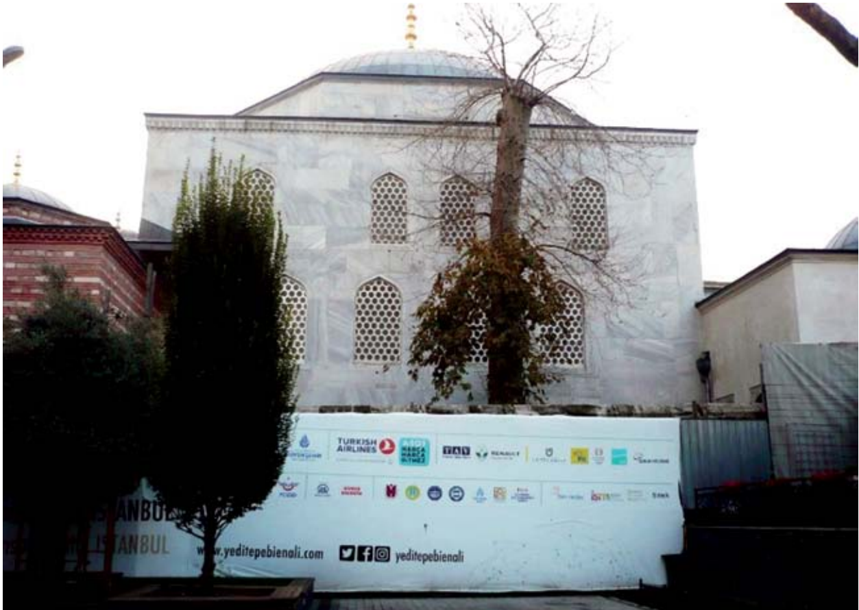
Şekil 16. Hatice Turhan Valide Sultan Türbesi sağ yan cephe restorasyon sonrası (İ. Billur Arşivi, 3.10.2018).
