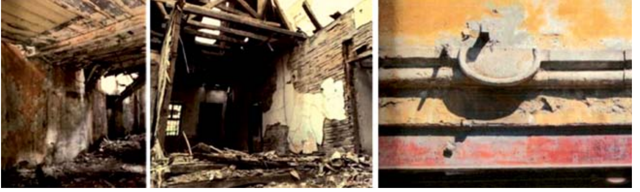
Şekil 22. 7306 ada, 6 parselde yer alan yapının rekonstrüksiyon öncesi durumu (Fersah Mim. Müh. İnş. Tic. Ve San. Ltd. Şti. Rölöve Raporu, 2015, Koruma Kurulu Arşivi).
