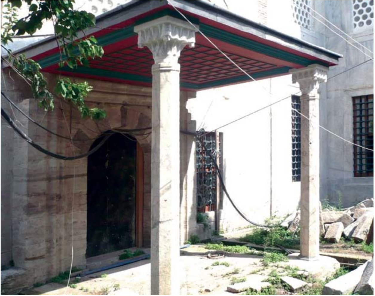
Şekil 35. Havatin Türbesi sol yan cephe giriş sakıf restorasyon sonrası (İ. Billur Arşivi, 01.08.2018).
