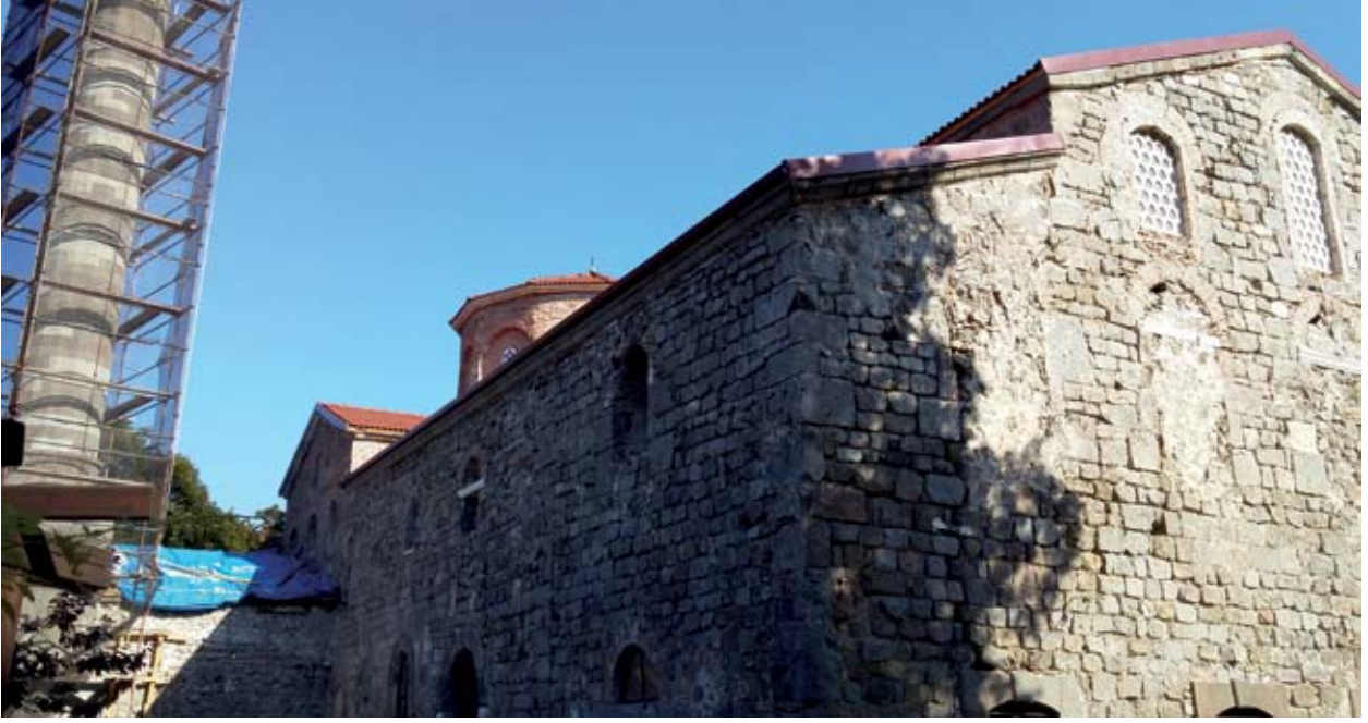
Şekil 9. Yapının batı cephesinin dış görünüşü.
