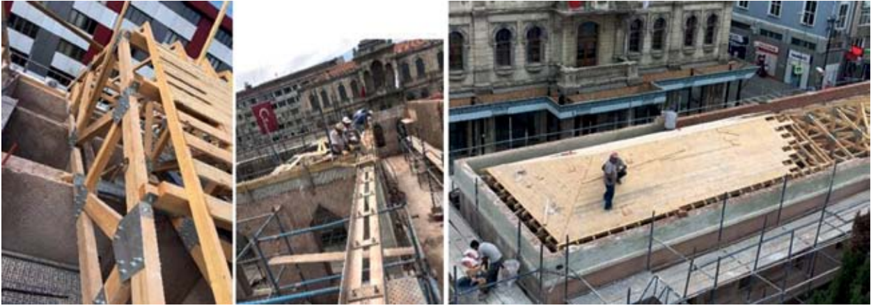
Şekil 18. Süleyman Paşa Medresesi 2018 restorasyon sahasında restorasyon öncesinde parapetlere oturtulmuş olan çatının özgün durumuna döndürüldüğü onarımı ve paslanmaz hatıl uygulaması.
