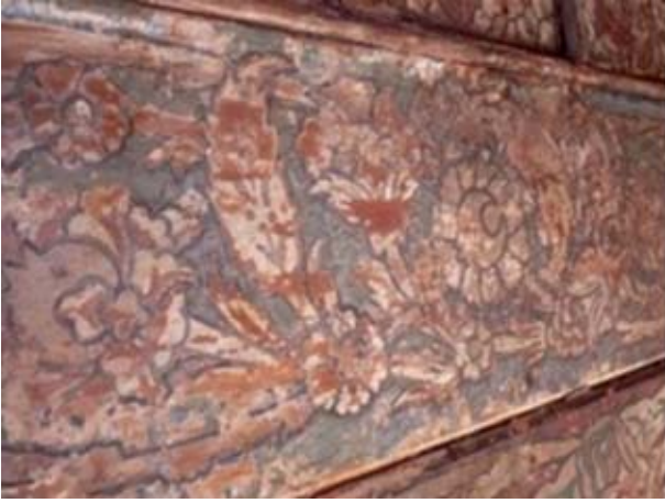
Şekil 19. Hatice Turhan Valide Sultan Türbesi saçak edirnekari çalışmaları (İ. Billur Arşivi, 2017).
