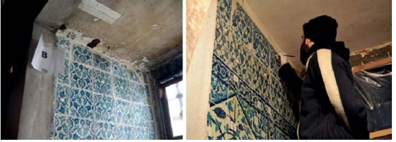
Şekil 20. Hatice Turhan Valide Sultan Türbesi çalışmaları çini sağlamlaştırma ve konservasyon işlemleri (İ. Billur Arşivi, 2016).
