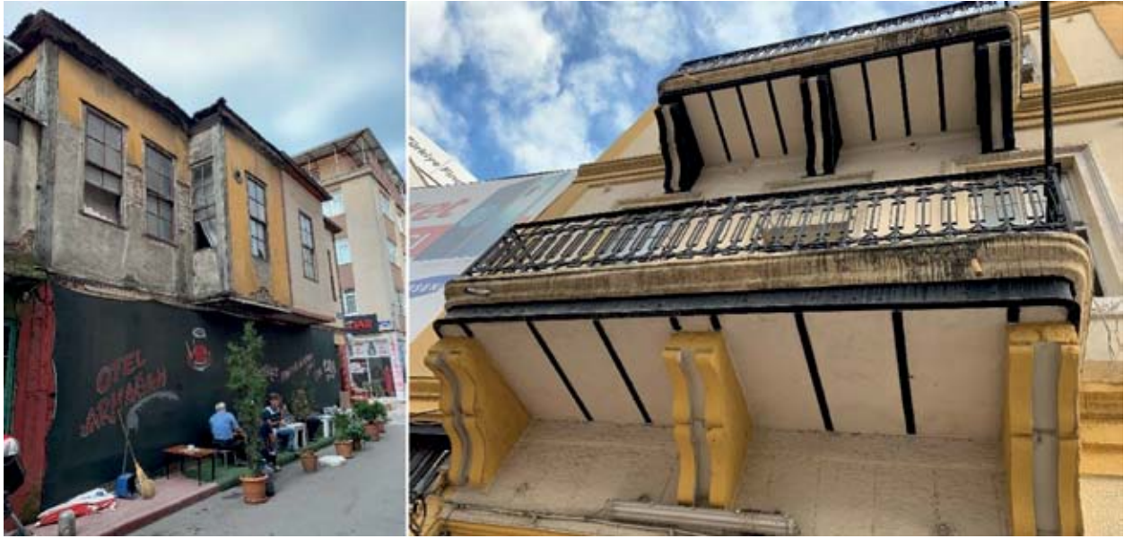
Şekil 14. (a) Dış bağdadi yapı örneği (b) Çıkma/saçak altı demir elemanlarla taşınan yapı örneği.
