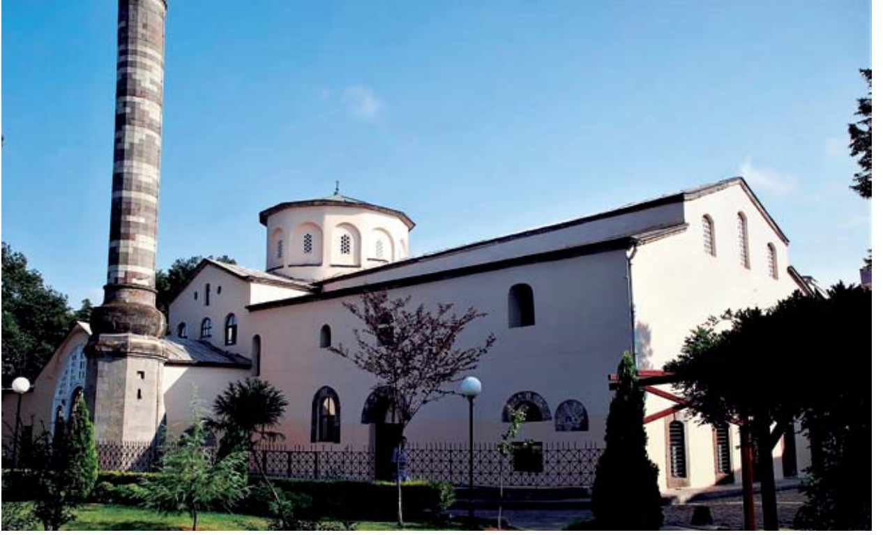
Şekil 5. Orta Hisar Camisi'nin restorasyondan önceki görünüşü.
