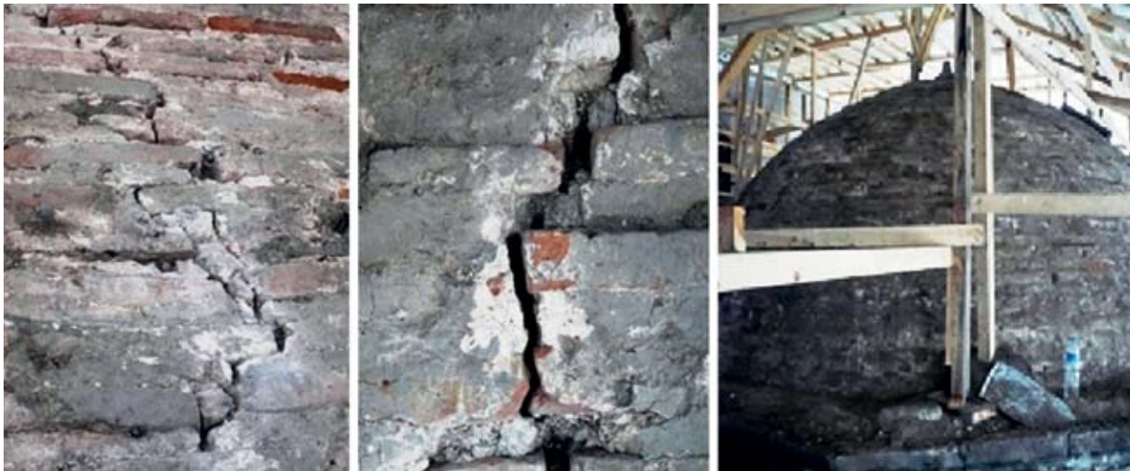
Şekil 13. Hatice Turhan Valide Sultan Türbesi ana kubbe güçlendirme çalışmaları (İ. Billur Arşivi, 2014).
