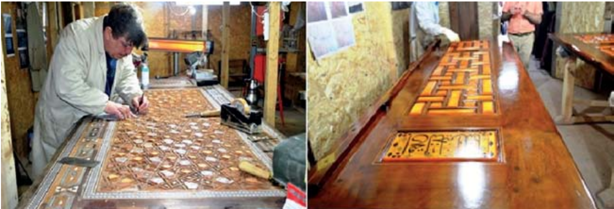
Şekil 28. Hatice Turhan Valide Sultan Türbesi ahşap sedef şebeke künde-kari restorasyon ve konservasyon çalışmaları (İ. Billur Arşivi, 2016).
