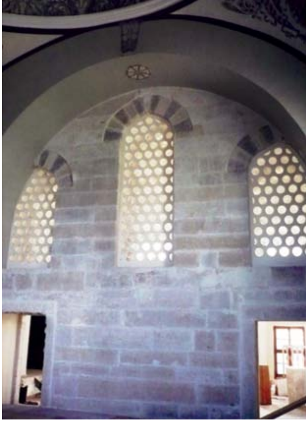
Şekil 37. Havatin Türbesi ile Cedit Havatin geçiş iç duvar ve dışlıklar restorasyon sonrası (İ. Billur Arşivi, 01.08.2018).
