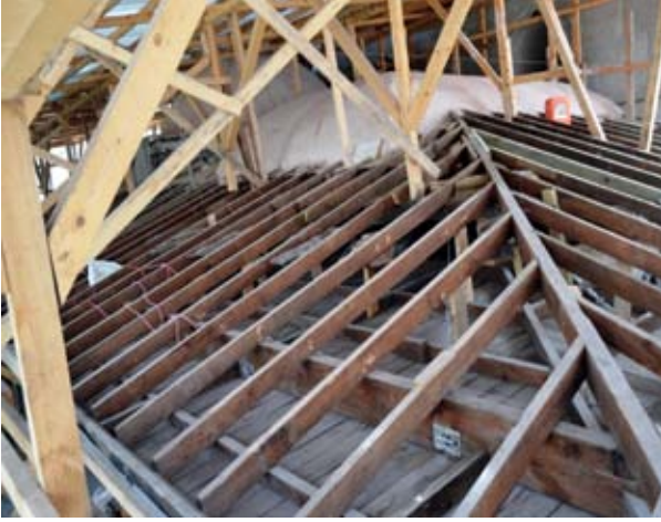
Şekil 17. Kuzeydoğu cephesi saçakta karkas ve merteklerin değiştirilmesi (İ. Billur Arşivi, 2017).
