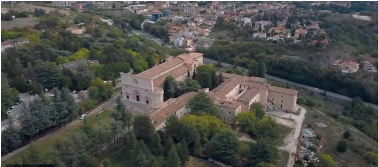
Şekil 16. Laquila'nın sembolik değeri çok yüksek yapılarından biri olan Santa Maria di Collemagio Kilisesi, restorasyon sonrası.
