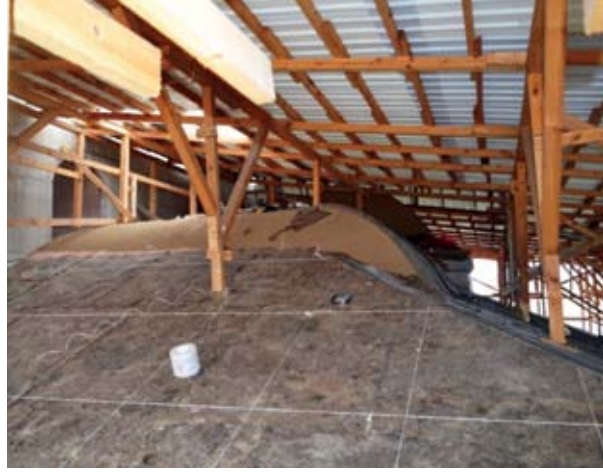
Şekil 18. Kuzeydoğu cephesi saçakta kurşun döşenmesi (İ. Billur Arşivi, 2017).
