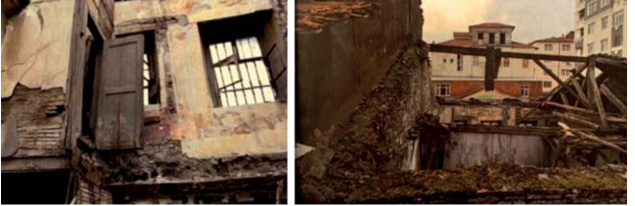
Şekil 23. Yapının demir profiller üzerine oturtulmuş ahşap wc'sinden rekonstrüksiyon öncesi durumu (Fersah Mim. Müh. İnş. Tic. Ve San. Ltd. Şti. Rölöve Raporu, 2015, Koruma Kurulu Arşivi).
