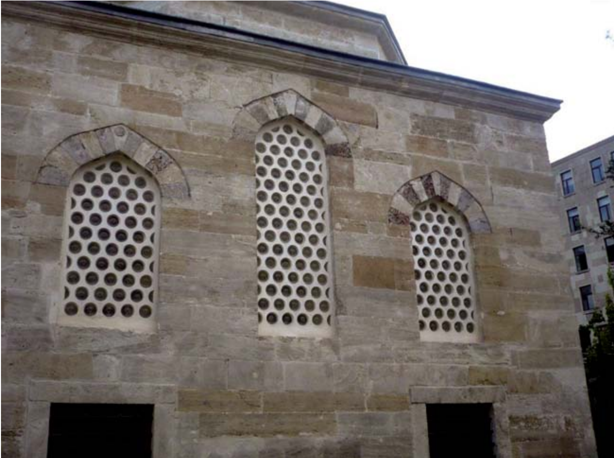
Şekil 34. Havatin Türbesi arka cephe restorasyon sonrası (İ. Billur Arşivi, 2018).
