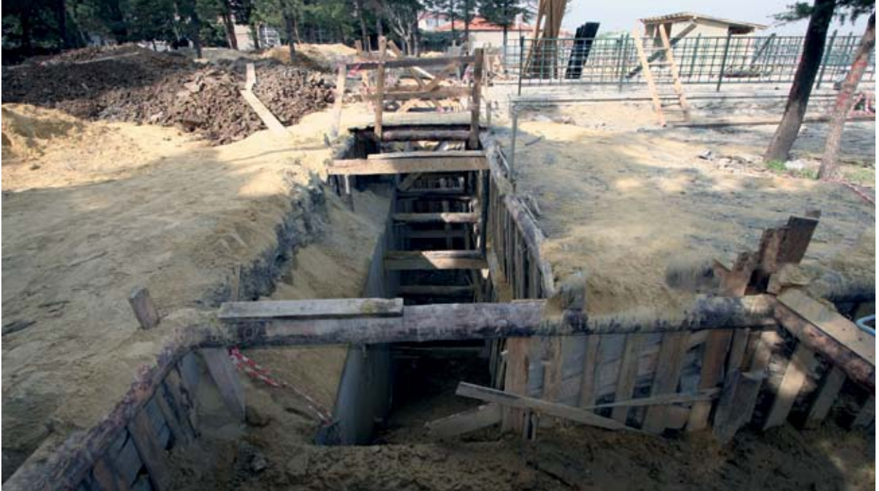
Şekil 1. Yavuz Selim Camii etrafında diyafram perde inşaatı.
