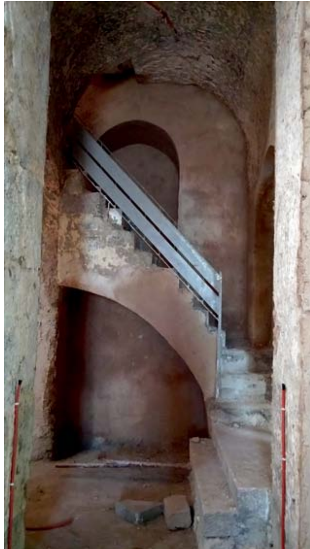
Şekil 22. Metatorion iç görünüşü ve üst galeriye çıkan merdiven. Figure 22. Metatorion internal. Stairs leading up to the gallery.
