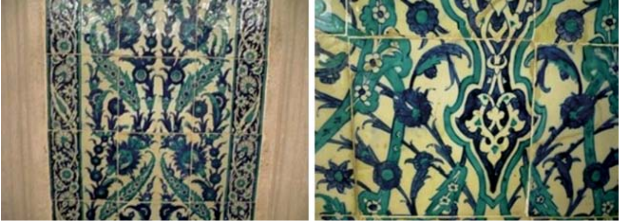
Şekil 21. Hatice Turhan Valide Sultan Türbesi çini sağlamlaştırma ve konservasyon işlemleri restorasyon sonrası (İ. Billur Arşivi, 2019).
