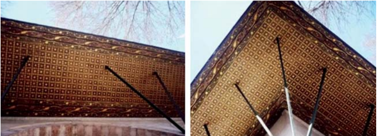
Şekil 47. Hatice Turhan Valide Sultan Türbesi girişinde Edirnekâri saçak restorasyon sonrası (İ. Billur Arşivi, 2019).
